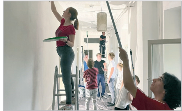
Renovierung beim Projekt Flüchtlingswohnung
